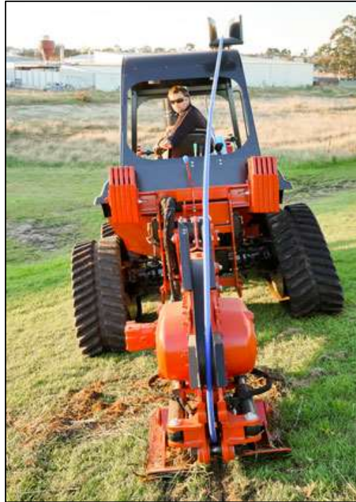
Plowed Cable-in Conduit
